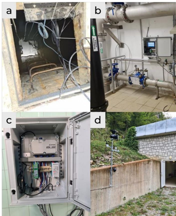
Slika 14: Fotografije točk črpališča Malni, kjer smo vgradili senzorje za različne namene meritev opozorilnega sistema. a) Jašek z vodo v katero so potopljene sonde; b) Pomožni registrator S::CAN con::cube vgrajen v 1. nadstropju objekta; c) Kontrolni registrator EltraTec vgrajen v 2. nadstropju objekta; d) Zunanja vremenska postaja
