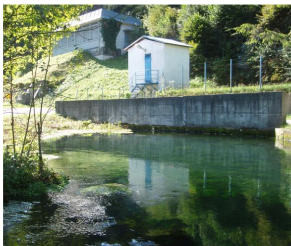
Slika 5: Izvir Malenščica na obrobju Planinskega polja je zajet za oskrbo s pitno vodo v občinah Postojna in Pivka.
